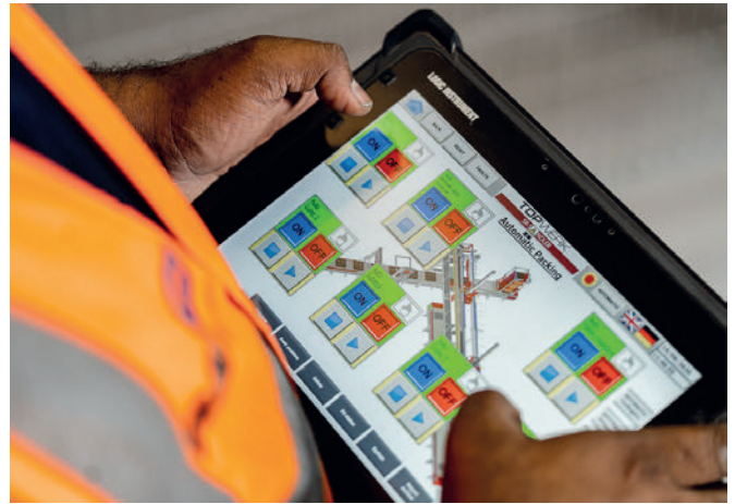
Funcionamiento manual controlado a distancia
