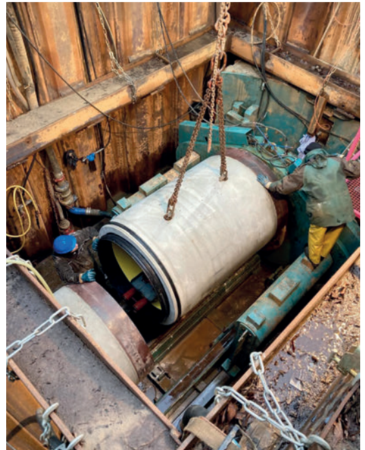
Üblicherweise sind die Platzverhältnisse im Rohrvortrieb beengt. Umso mehr wiegt der Vorteil von Perfect Jacking Pipe, wonach bereits mit dem Einschleiben des nächsten Rohres ein komplettes, korrosionsgeschütztes Leitungssystem hergestellt ist.
