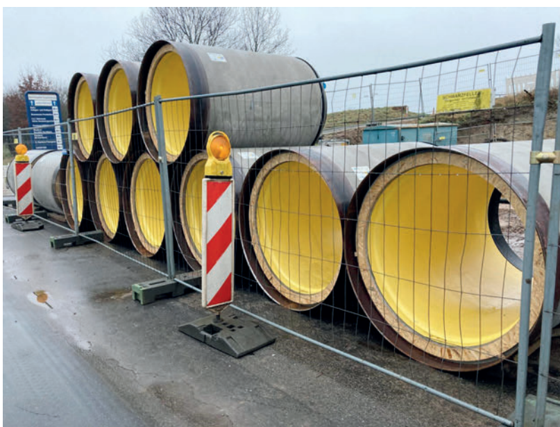
Typisches Perfect-Pipe-Baustellenlager (Haren, Deutschland). Es wurden hier 2021 erstmals in Deutschland Perfect-Pipe-Vortriebsrohre DN 1200 eingepresst.
