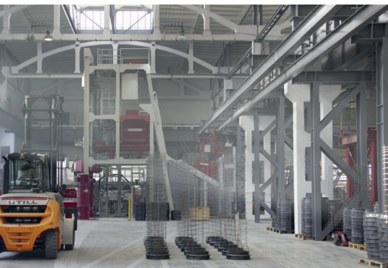
Производство железобетонных труб на радиальном прессе завода «Минскметрострой»
