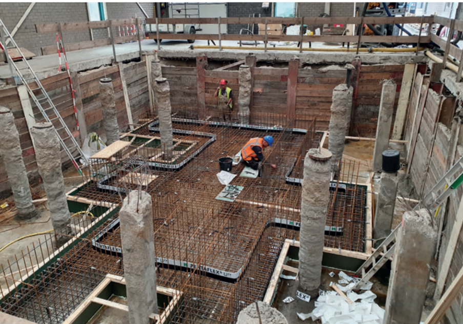
Подготовленная площадка для бетоноформовочной машины перед бетонированием
