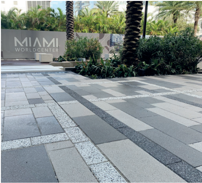
Укладка брусчатки Wausau
