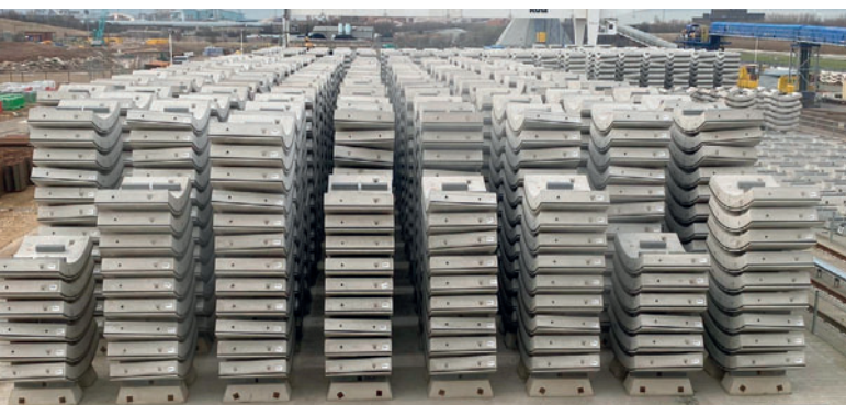
Склад для промежуточного хранения тюбингов – сборных ж/б элементов для тоннельной обделки
