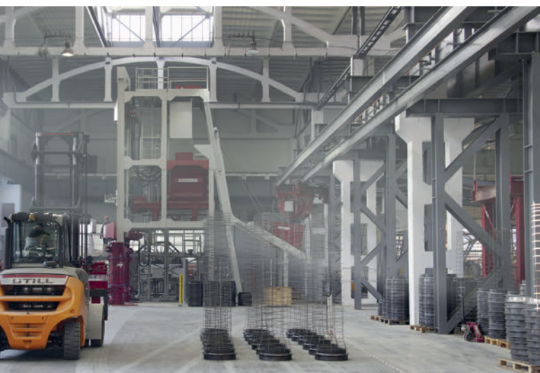
Produzione di tubi in calcestruzzo con la pressa radiale presso lo stabilimento di produzione del calcestruzzo Minskmetrostroy
