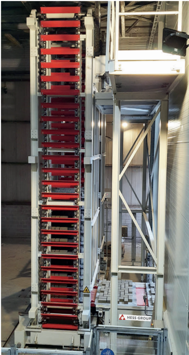
Sistema elevatore, foto dal lato della camera di stagionatura
