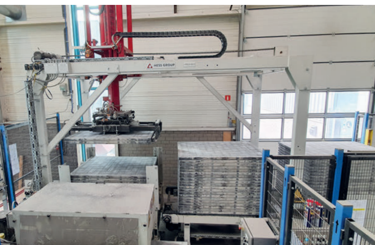
Nastro di accumulo tavole con gru di accatastamento e silo tavole
