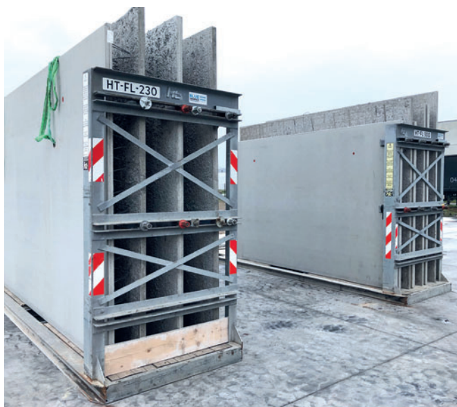
Elementi a doppie pareti pronti per il trasporto in cantiere
