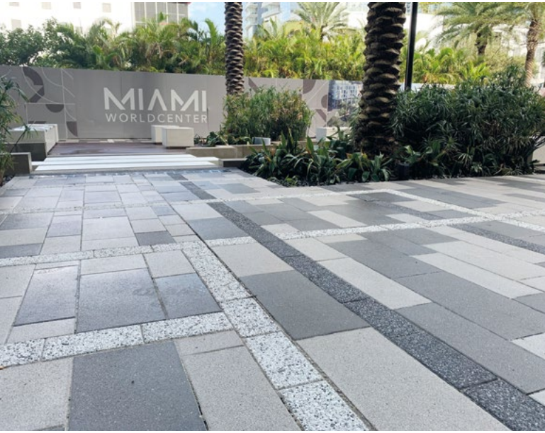
Pose de pavés de Wausau
