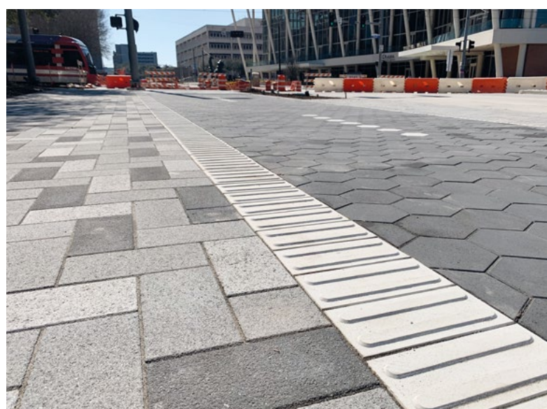
Bagby Street : pose de pavés dans la zone pour piétons et cyclistes
