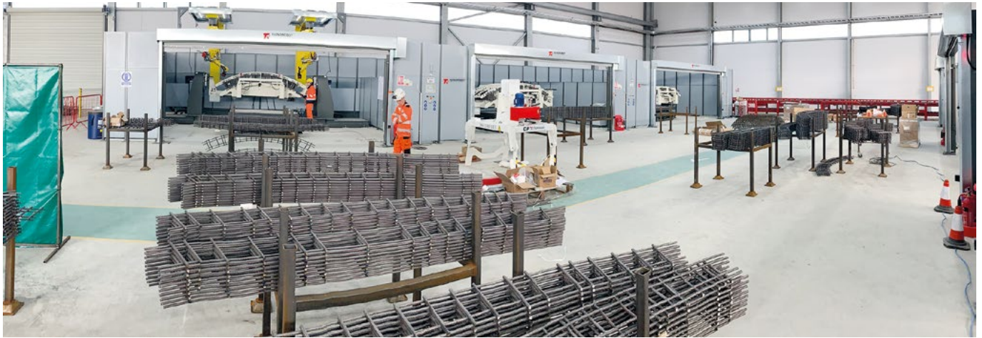
Les échelles préfabriquées sont soudées avec les treillis d'armature par les robots de soudage (visibles à l'arrière-plan) pour former la cage finie des éléments de tunnel.
