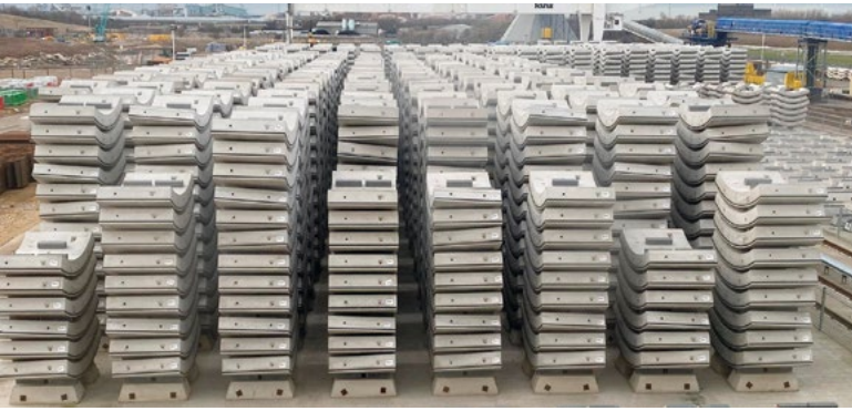
Stock intermédiaire des cuvelages - les éléments préfabriqués bétonnés pour le voile extérieur du tunnel
