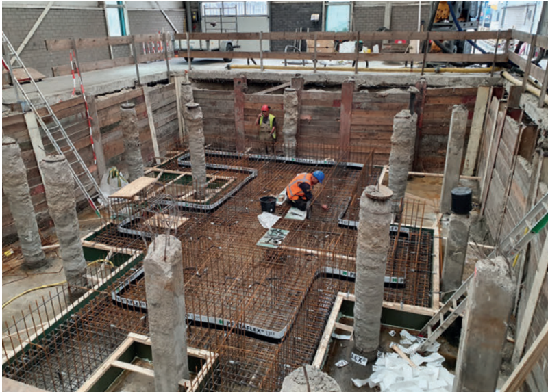
Construcción de la cimentación de la máquina
