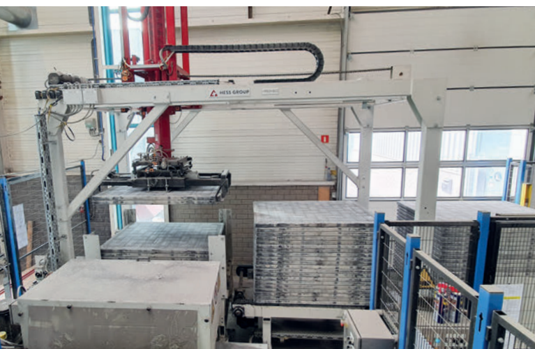
Vía de almacenamiento intermedio de bandejas con grúa de apilamiento y silo de bandejas
