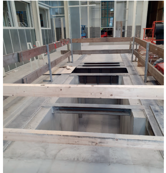
Cimentación de la máquina poco antes de la instalación
