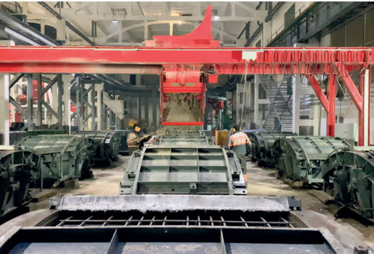
Das neue Betonverteilersystem für die Tunnelschalungen
