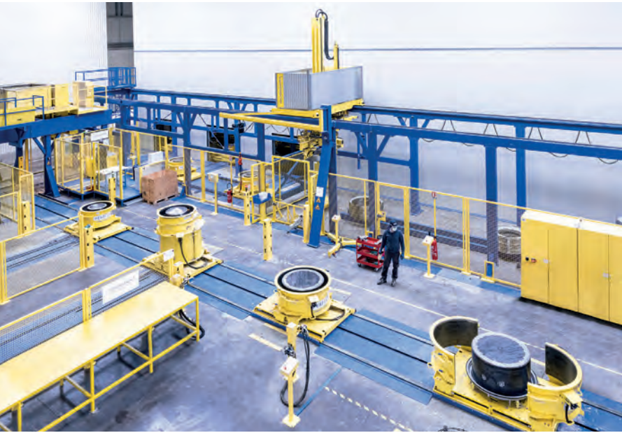
Промышленное производство: независимо от требуемых усилий по переналадке каждая форма на производственной линии передается в зону заливки в соответствии с рабочим циклом
