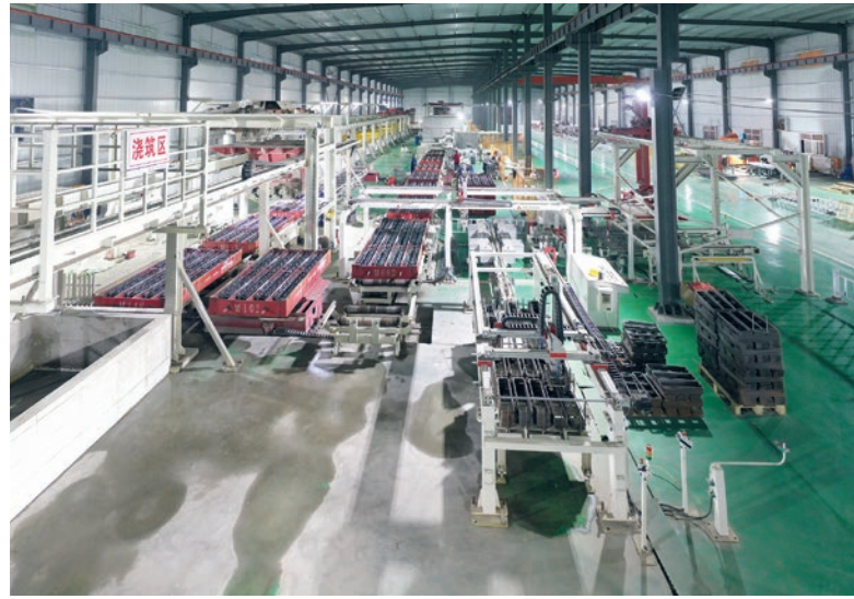
Fig. 12: Montaggio completamente automatico di elementi incorporati/acciaio d'armatura
