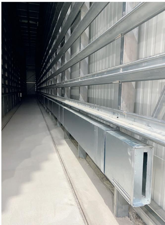
*Affinché il clima sia il più omogeneo possibile per tutta la profondità, larghezza e altezza della camera singola, i pozzi di ventilazione del sistema Quadrix-Ultra hanno molte prese d'aria.*
