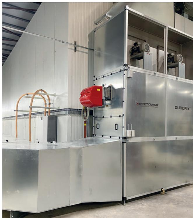
*L'impianto di tempra del calcestruzzo Quadrix-Ultra di Kraft Curing Systems provvede al clima ideale nelle camere singole della camera di tempra.*
