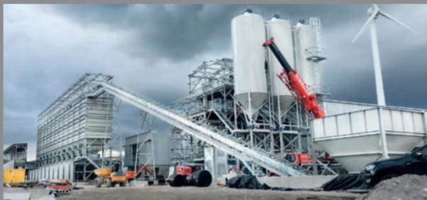
*L'impianto di dosaggio e di miscelazione di Rapid International nella fase di montaggio: a destra la torre di miscelazione con i tre silos di cemento di 150 tonnellate, a sinistra le unità con complessivamente 29 tramogge per gli aggregati e la sabbia.*
