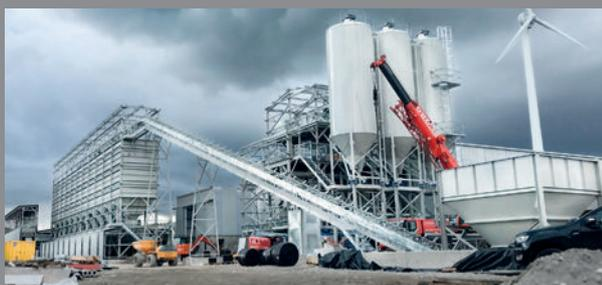
*L'installation de dosage et de mélange Rapid International en phase d'assemblage : à droite, la tour de malaxage avec les trois silos à ciment de 150 tonnes, à gauche les unités avec un total de 29 trémies pour les granulats et le sable.*
