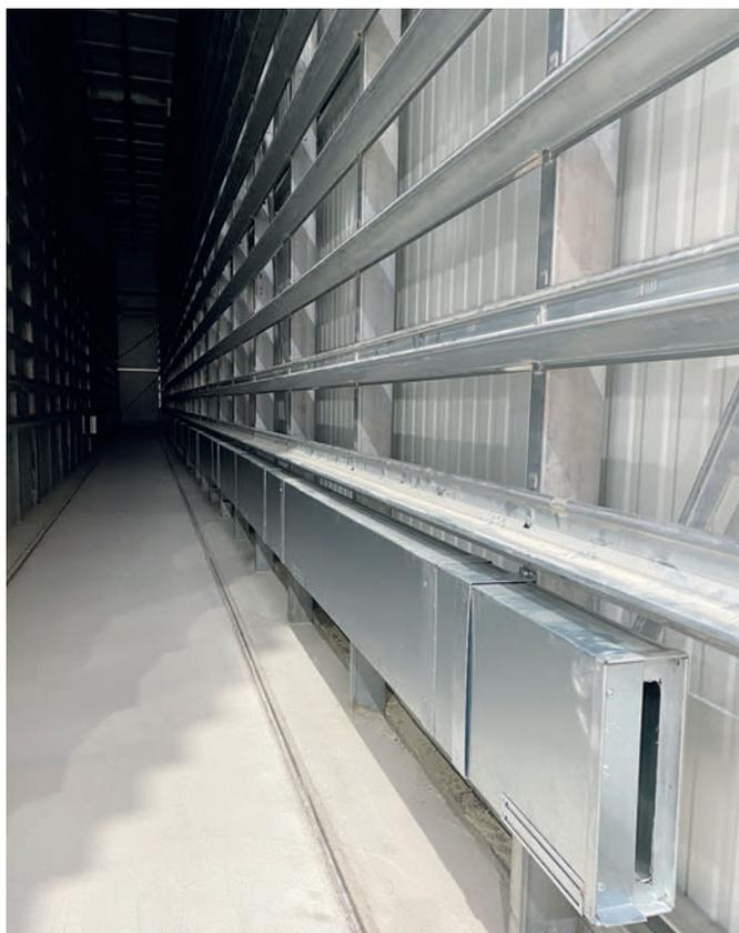
*Afin de garantir un climat aussi uniforme que possible sur toute la profondeur, la largeur et la hauteur de chaque chambre, les puits d'air du système Quadrix Ultra sont équipés d'un grand nombre de volets de ventilation.*
