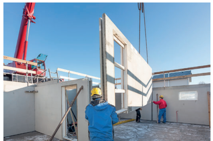
L'installation des caves Schwörer - la base des maisons préfabriquées Schwörer.
