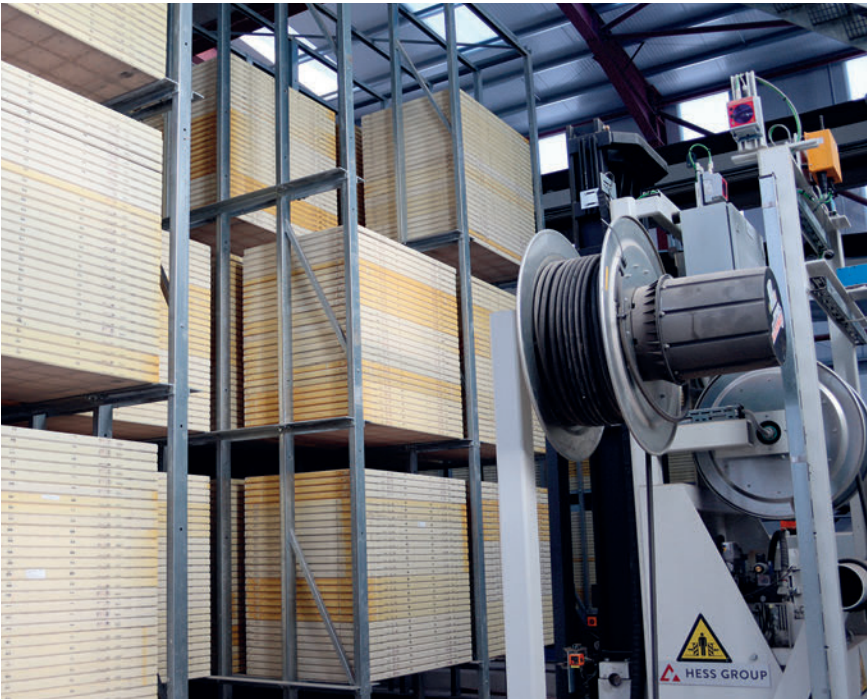
El almacén temporal de bandejas al inicio del lado húmedo tiene capacidad para 3240 bandejas.
