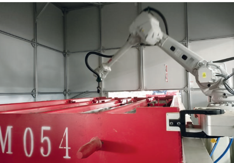
Fig. 3: Pulverizado con robot de agente desencofrante
