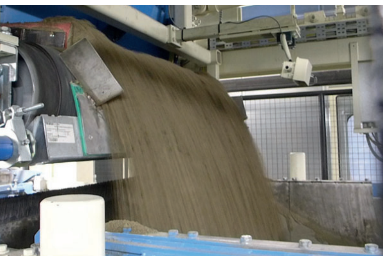
Заполнение загрузочной вагонетки с помощью дозирующего ленточного транспортера
