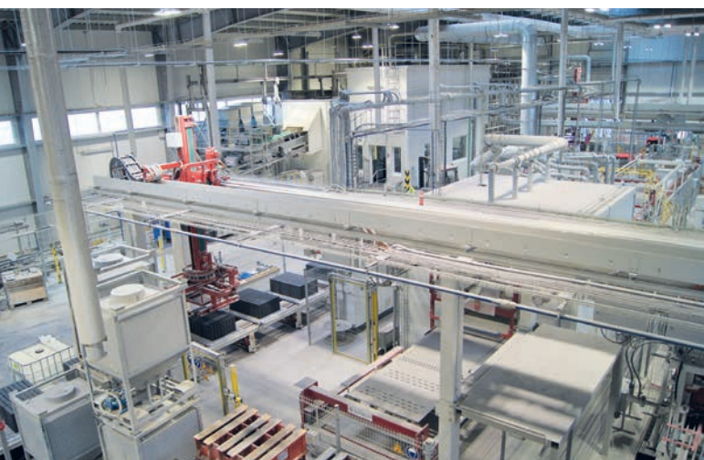
Panoramica dell'impianto: sull'estrema sinistra la linea dell'umido, al centro quella del secco e a destra le linee di trattamento
