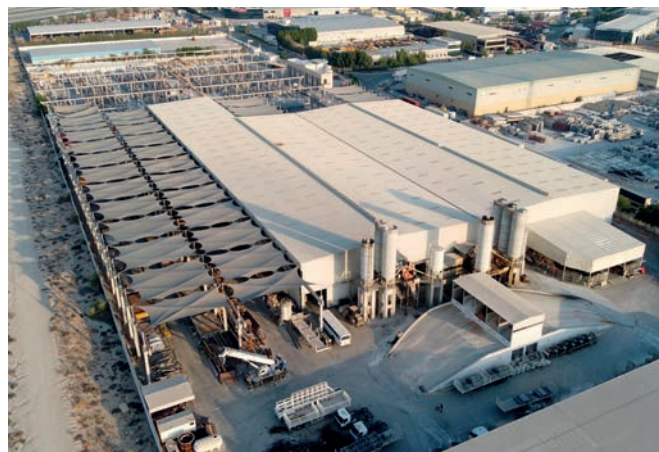
Uno sguardo all'area aziendale della Hard Precast di Dubai e ai prefabbricati in calcestruzzo che vi sono depositati.
