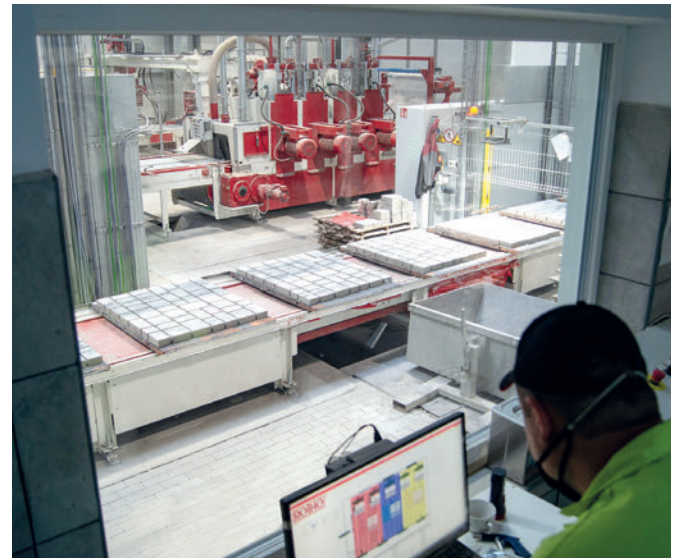
Vista desde la cabina de control en el lado seco de la producción; en el fondo se encuentra la máquina de curling de SR Schindler
