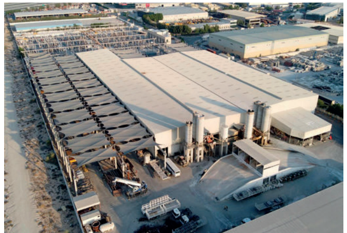
Vista del recinto empresarial de Hard Precast en Dubái y los prefabricados almacenados.
