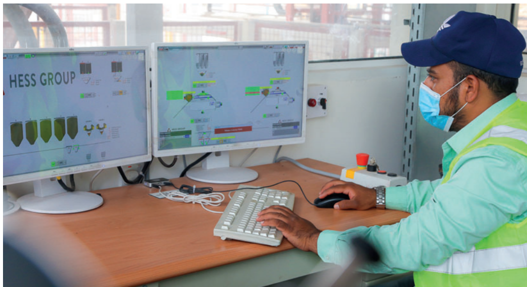
Контроль работы БСУ
