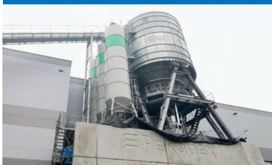
Заполнители попадают в бункер на ленточном транспортере длиной 70 м, где вращающаяся лента распределяет их по отдельным камерам
