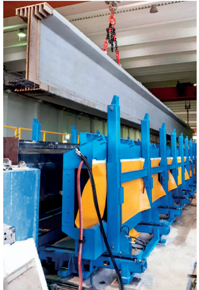
Retirada de la viga fabricada del encofrado variable con secciones de ajuste individualizado
