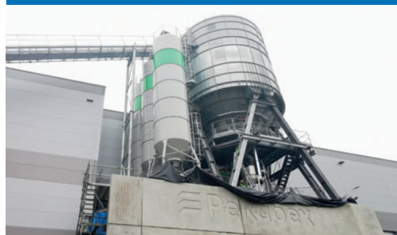
Über ein 70 m langes Transportband gelangen die Zuschläge in das Silo, wo ein drehbares rotierendes Band sie auf die einzelnen Kammern verteilt.
