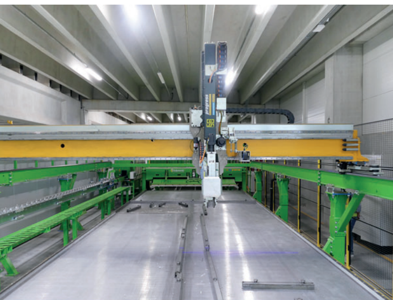
Das neue Pekabex-Werk in Polen besticht durch einen hohen Automatisierungsgrad, beginnend beim Scannen der Palettenoberfläche und dem vollautomatischen Entnehmen der Absteller durch den Entschalroboter.
