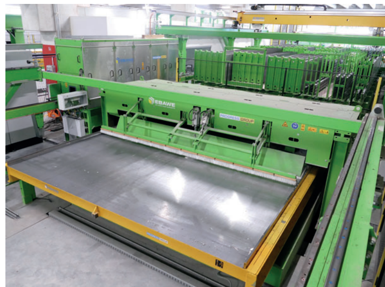
Eine hochwertige Oberfläche der Endprodukte wird erreicht, indem die Paletten vor dem neuen Produktionszyklus eine Reinigungseinrichtung passieren. Die Betonreste werden über ein Schuttband zur Weiterverarbeitung abtransportiert.
