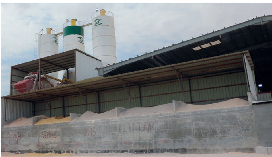
Produktionsstätte von Riyadh Kingdom Concrete Products Al Ahsa
