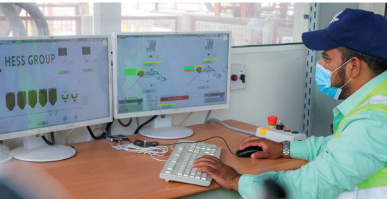
Steuerung der Mischanlage
