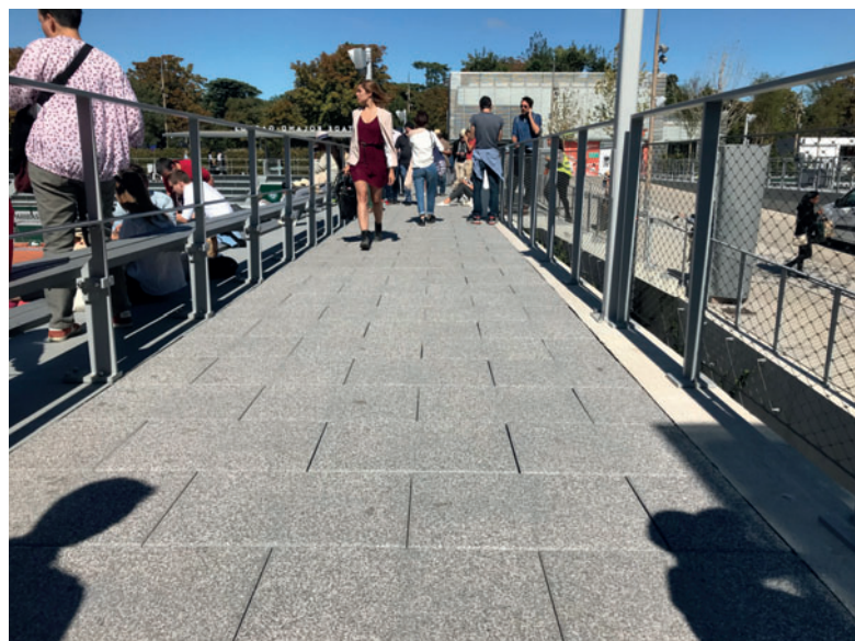
Укладка плит в пешеходной зоне
