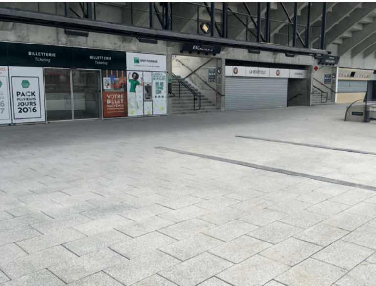
Укладка плит во входной зоне
