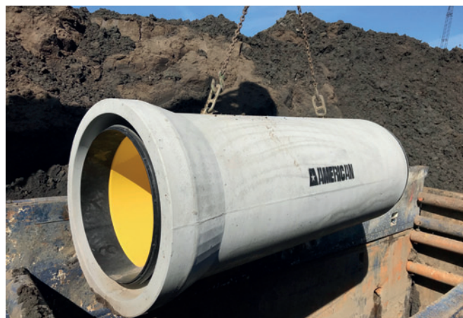
Montaż systemu American Perfect Pipe w Nebrasce. Odporny na korozję rurociąg z elastycznymi połączeniami rurowymi powstaje zaraz po instalacji.
