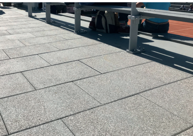
Szczegółowy widok płyt betonowych.
