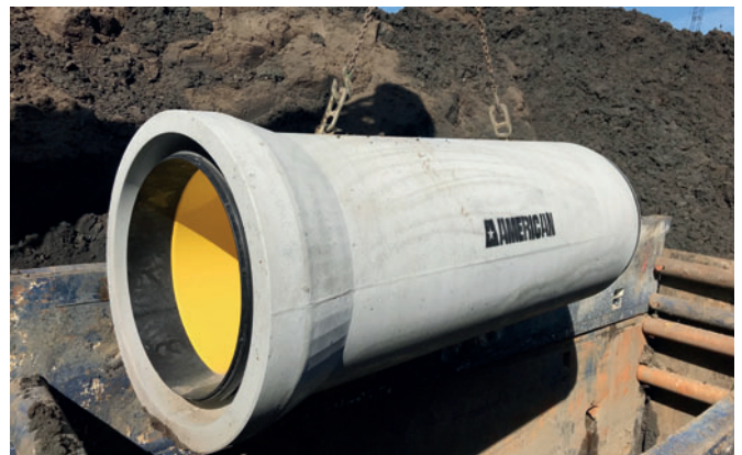
Pose de Tuyaux Perfect américains dans le Nebraska : immédiatement après la pose du tuyau on obtient une canalisation flexible et protégée contre la corrosion.
