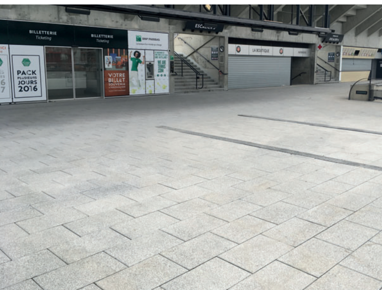
Pose dans la zone d'entrée
