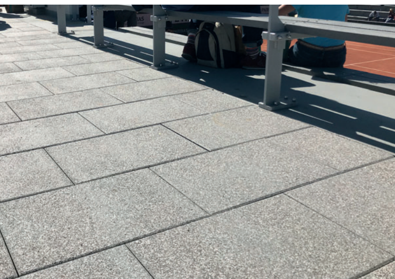
Vue détaillée des dalles en béton
