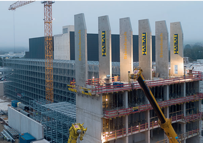
Montage von speziellen Betonfertigteilen auf der Baustelle
