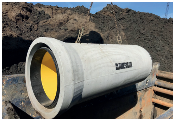
American Perfect Pipe wird in Nebraska eingebaut: Unmittelbar nach dem Einbau des Rohres ist ein korrosionsschutztes flexibles Rohrsystem hergestellt.
