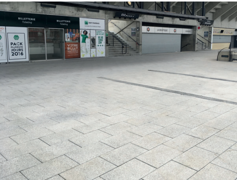
Verlegung im Eingangsbereich
