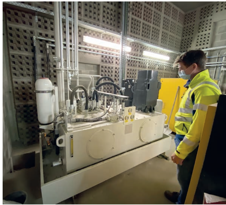
Fig. 5: Sistema hidráulico de la prensa
