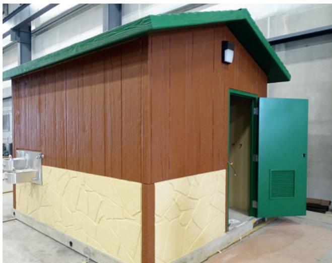
Компания Huffcutt производит санитарные блоки из сплошных ж/б элементов и собирает их непосредственно на заводе, комплектуя их всем санитарно-техническим оборудованием. Небольшие здания выполнены в архитектурном стиле с использованием цветного бетона и матриц с имитацией плитки, камня или древесины
