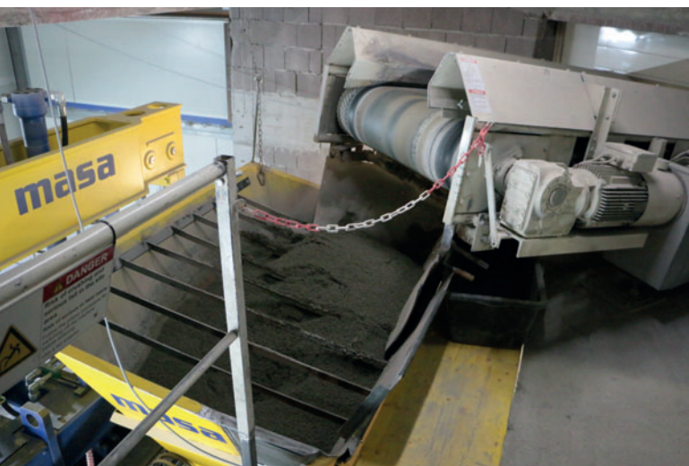
Ленточный транспортер для загрузки бункера для опорного бетона
