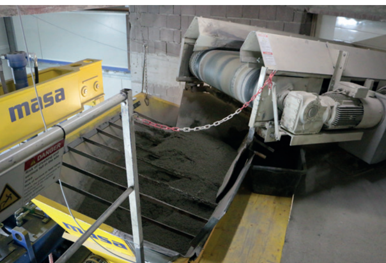
Napełnianie zasobnika mieszanki konstrukcyjnej.
