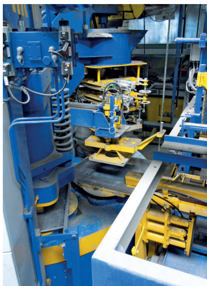
Stanowisko wypychania z urządzeniem odbiorczym (w tle dozownik rurowy).
