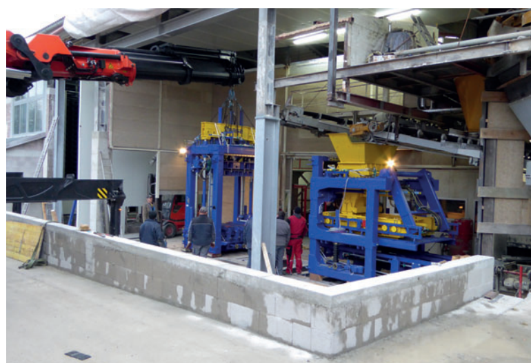
Installazione della componente compattazione della nuova Masa XL9.1.
