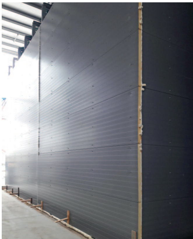
Tous les joints entre les panneaux isolants sont parfaitement étanches afin d'éviter les pertes de chaleur. Un petit détail qui empêche la condensation, prévient la corrosion et réduit les dépenses énergétiques.
