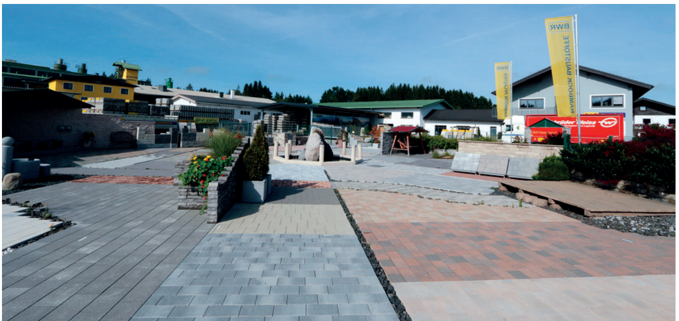
La planta de hormigón Ramböck es desde hace décadas sinónimo de calidad.
