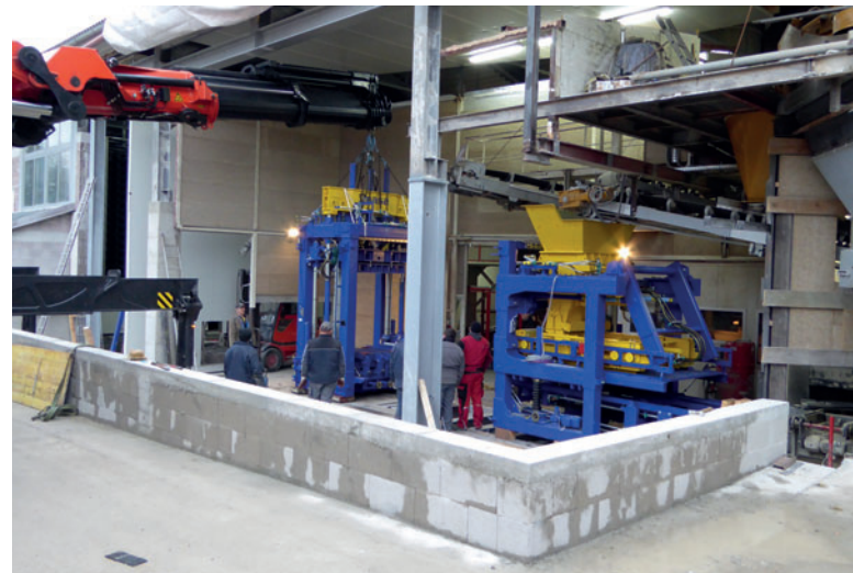
Instalación de la unidad de compactación de la nueva Masa XL9.1.
