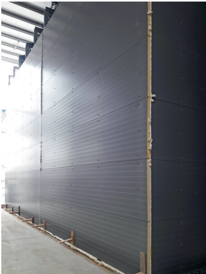
Detalle obsesivo típico de Kraft: todos los puntos de conexión entre los paneles sándwich son estancos al aire
