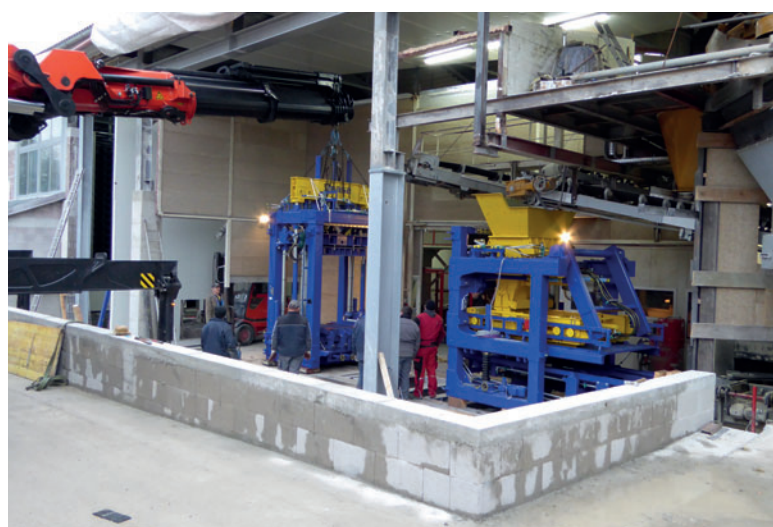
Das Verdichtungsteil der neuen Masa XL9.1 wird installiert.
