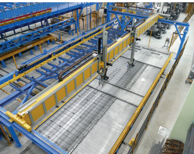
Un robot lineare multiasse completa l'area automatizzata adibita all'armatura nella nuova fabbrica di Eder.
