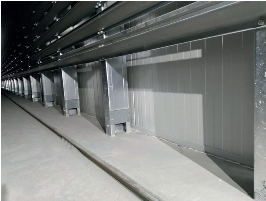
Abb. 5: Durch die Einbeziehung sämtlicher Stützen an der Kammerwand verschiebt das Kraft-Regal den Taupunkt der Bodenplatte nach außen und beugt so Kondensation und Korrosion vor. (Bild: Kraft Curing Systems)
