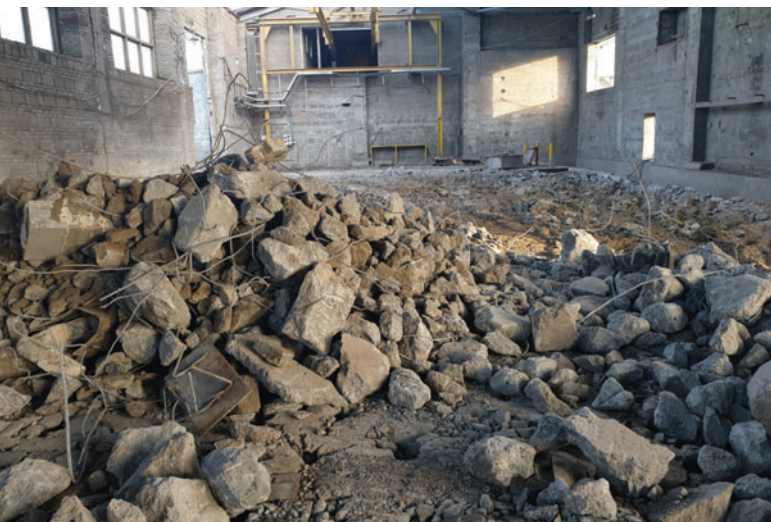
Работы по демонтажу идут полным ходом
